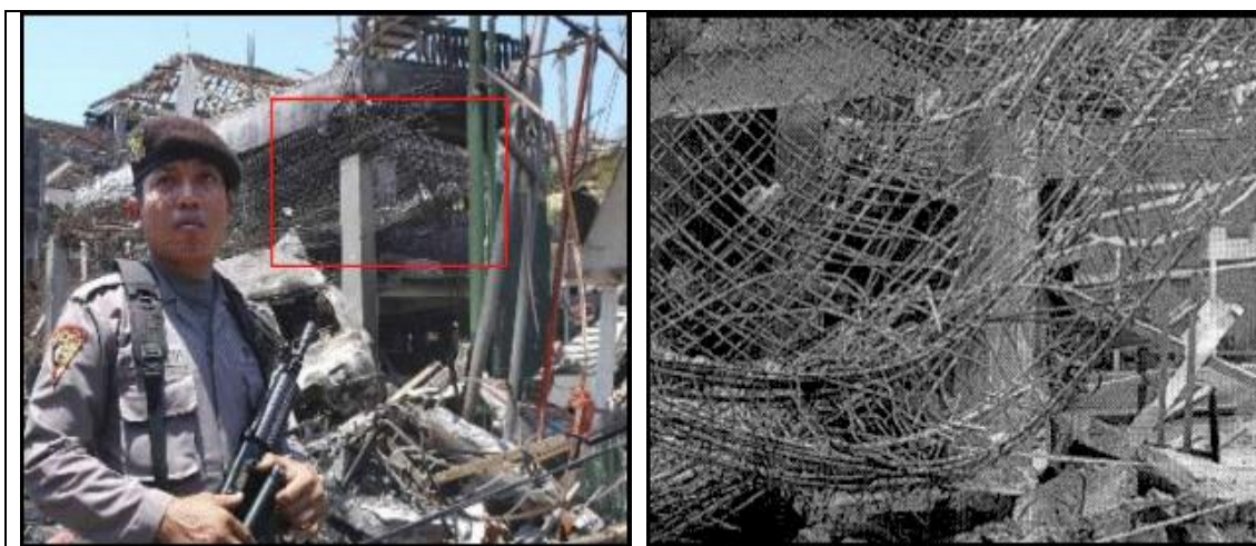
Бетон, полностью сорванный с арматуры, более чем 50 футов от эпицентра взрыва
